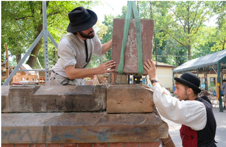
Die Steinblöcke werden mit Hilfe von Ketten und Seilen auf die Mauern transportiert. Während
