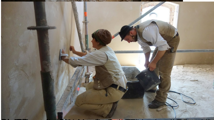
Die Plasterer sind dabei die Wand mit einem Mörtel zu beschichten und die Wand zu putzen und die
