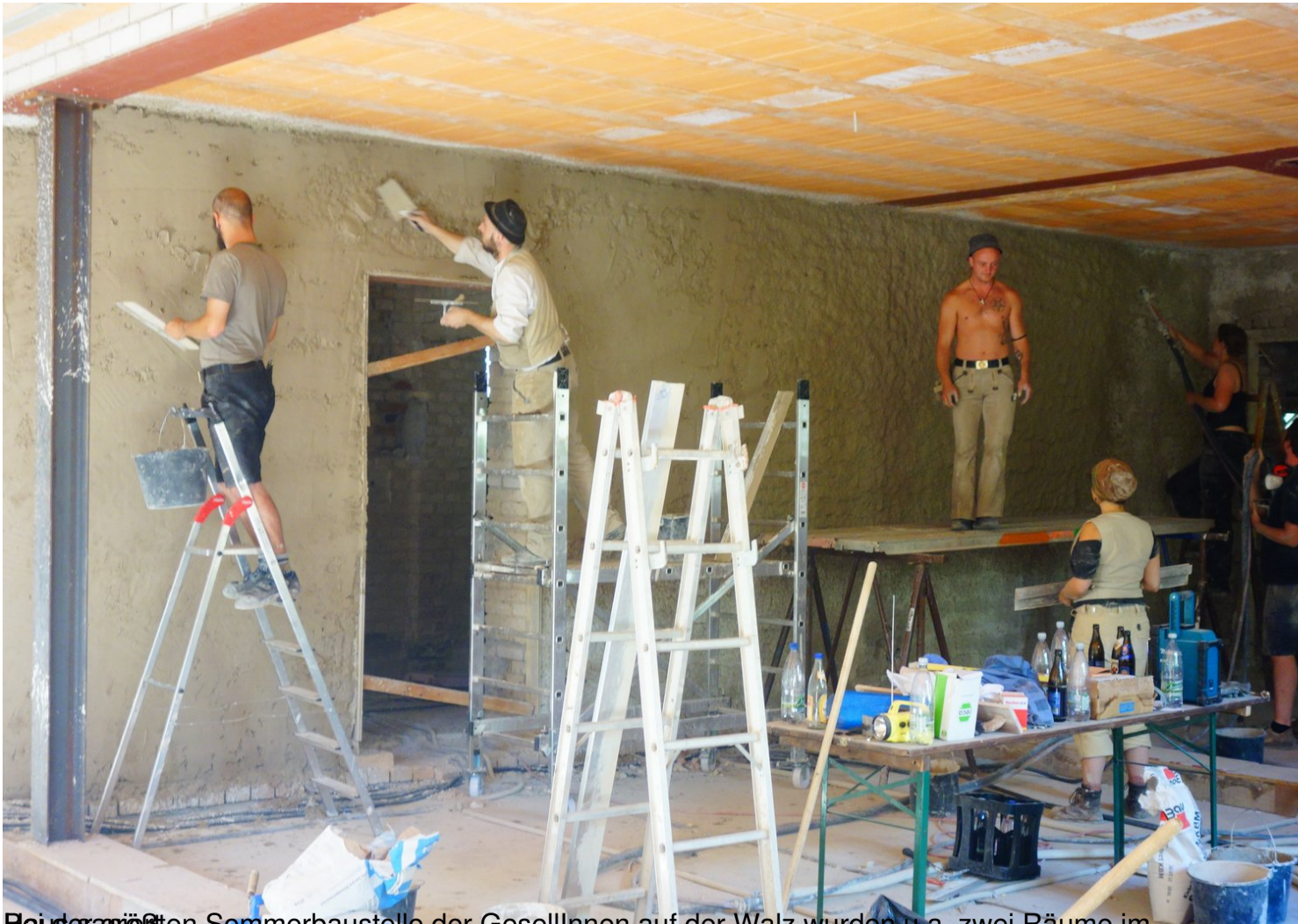
Bei der gerichteten Sommerbaustelle der GesellInnen auf der Walz wurden u.a. zwei Räume im
