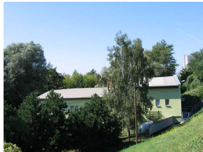
Anglerheim Mansfelder Straße (ehmalige Gaststätte des Luisenbades)
