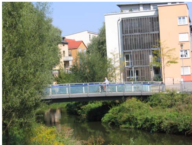
Die neue Hallorenbrücke westlich der Händelhalle
