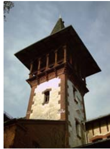
Turm des Peißenitzhauses
