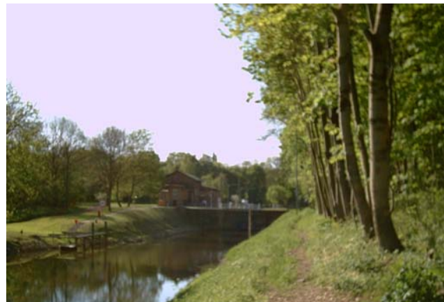
Nördliche Einfahrt zur Trothaer Schleuse
