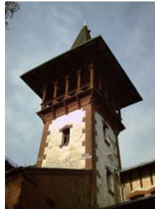
Turm des Peißnitzhauses
